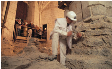
Los visitantes siguen en directo las obras de restauración.
