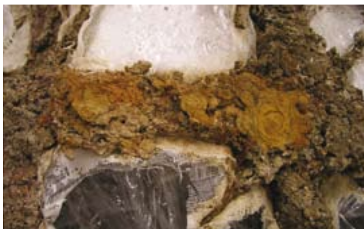
Foto 3. Aspecto de los productos de corrosión del hierro
