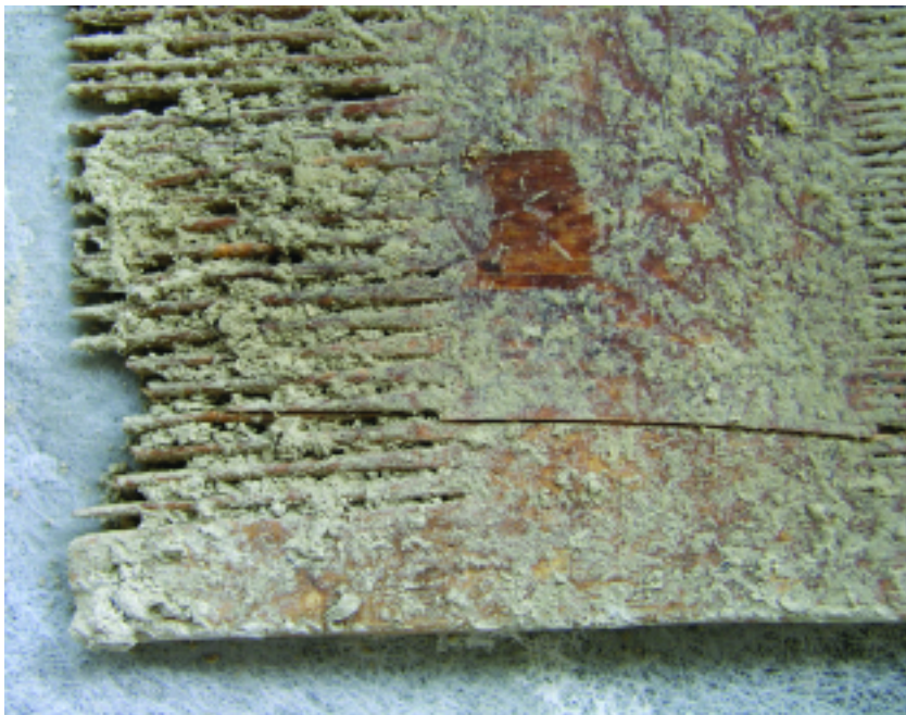
Foto 2. Con el refuerzo, cata de limpieza
