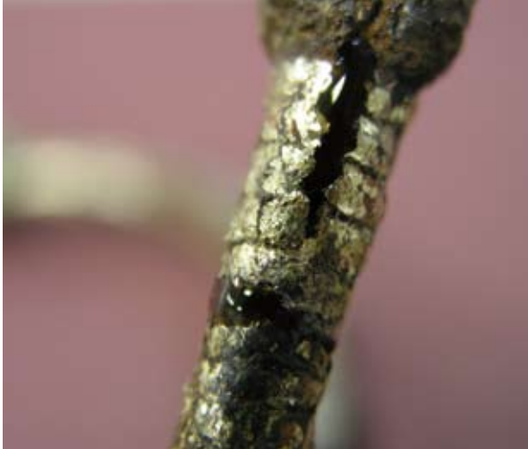
Refuerzo de una grieta con resina epoxídica
